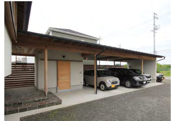
車庫・バイク小屋 玄関と屋根が繋がった車庫とバイク小屋。車からの出入りの際に雨に濡れずに移動できるのがポイント。屋根下空間はとても便利で、これからの梅雨の季節に重宝するスペースとなる。
