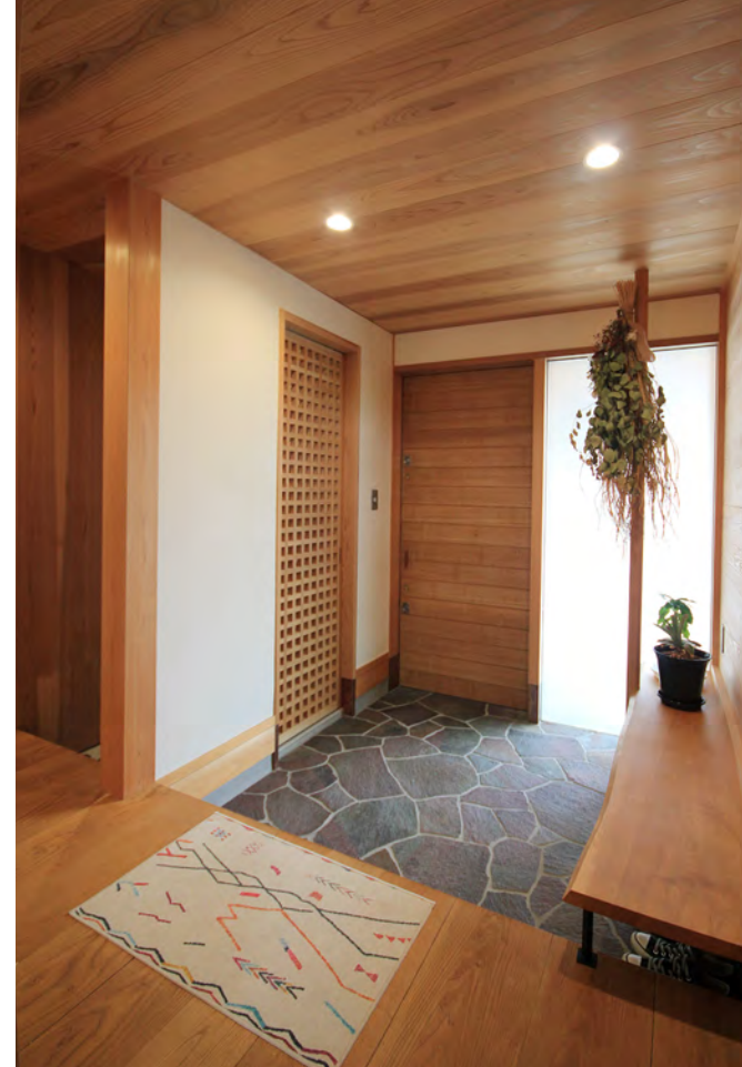
玄関 土間仕上げを諏訪鉄平石の乱張りにし、来客が腰掛けられるベンチを設けた。シューズクロークとの間に格子戸を設け、玄関の雰囲気を上げている。北玄関ではあるが、袖ガラスからの優しい光が全体を明るくし、機能的にも問題のない玄関となっている。
