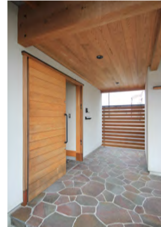
玄関ポーチ 玄関と同様に諏訪鉄平石で仕上げたポーチ床。職人の技量とデザインセンスが求められる仕上げで、ココラボでは、石屋の石川さんでなければ頼めない仕事。
