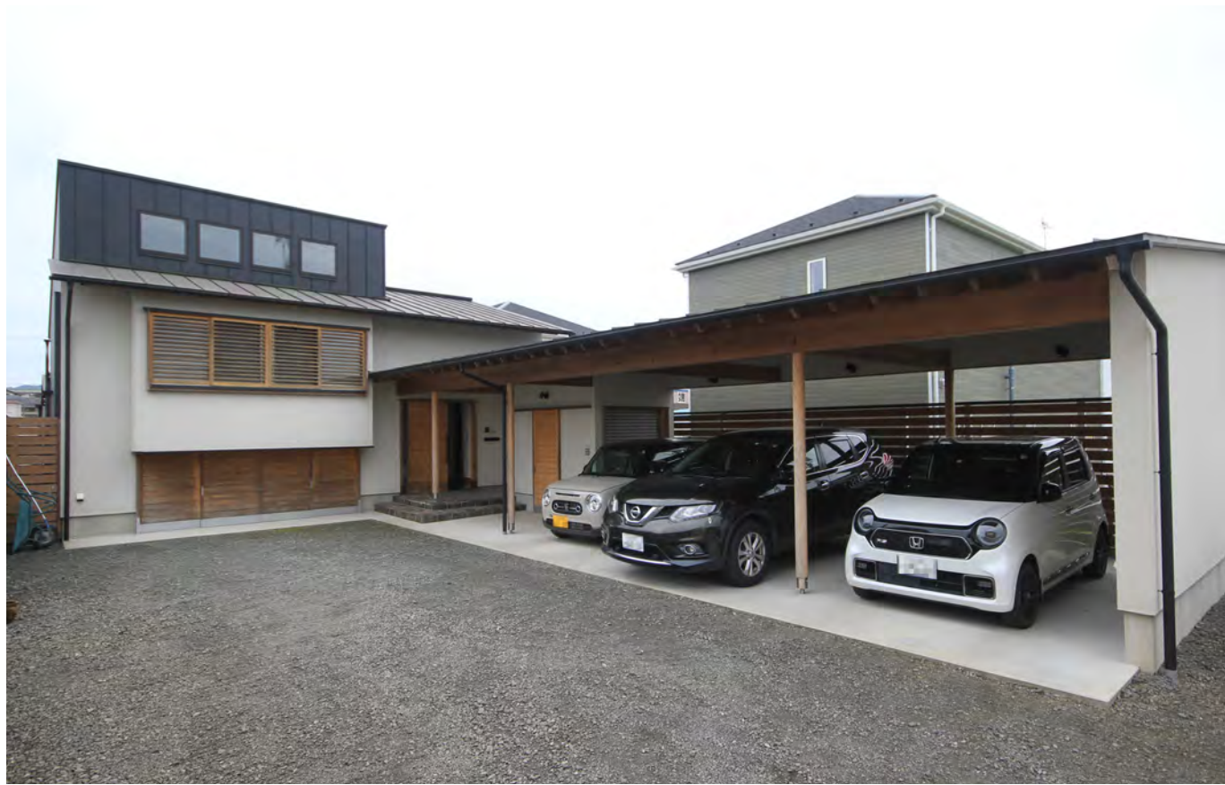
北側から見た外観。駐車スペースとして3台分の車庫を建物に合わせた外観となっている。縦長の敷地に対して車の回転スペースを確保し、スムーズな出入りが出来る駐車スペースになった。
