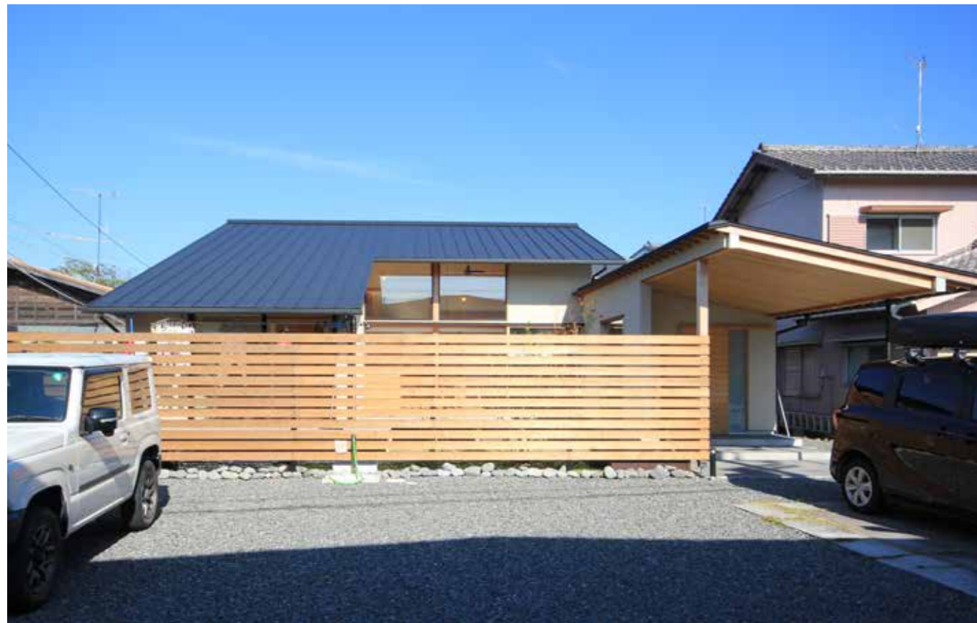
南側の外観。大きな窓のある中庭は板塀で囲まれ、道路や隣地、駐車場からの視線を遮っている。開放的な暮らしを楽しむためにはプライバシーを守る工夫も重要。板塀は高さ1.8m~2m程度とし、3cm程の隙間を空けている。
