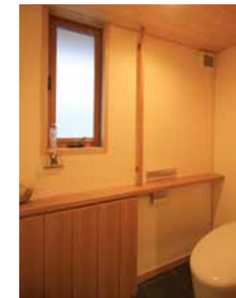
トイレ 収納カウンターと手摺を一体化したオリジナル家具を製作。省スペースながら機能面を重視し、ストレス無く使いやすいデザインとしている。
