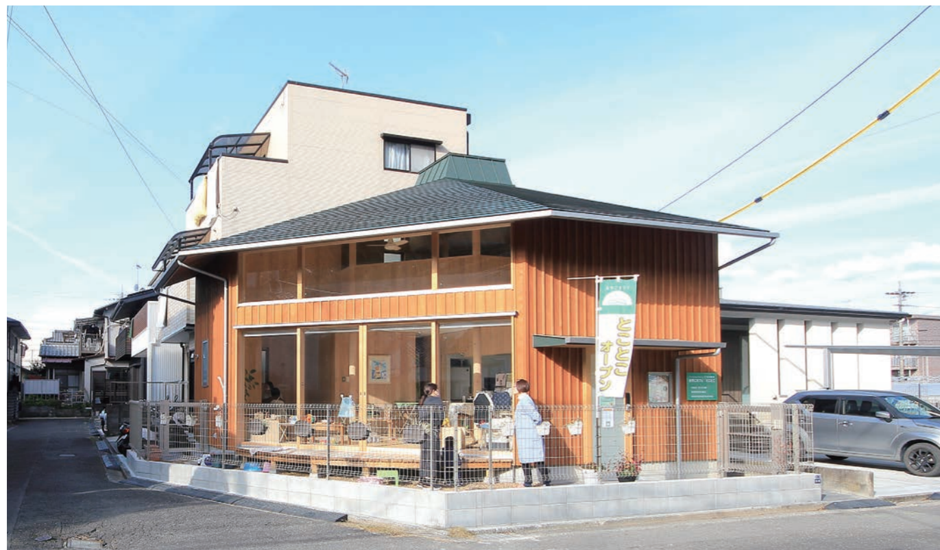
大きな隅切りのある変形敷地を利用して、少し変わったホームベース型の間取りを提案した。外部からは少し分かりにくいですが、屋根形状が扇状になっている。外壁はオクシズ材の杉の赤身を縦張りした。
